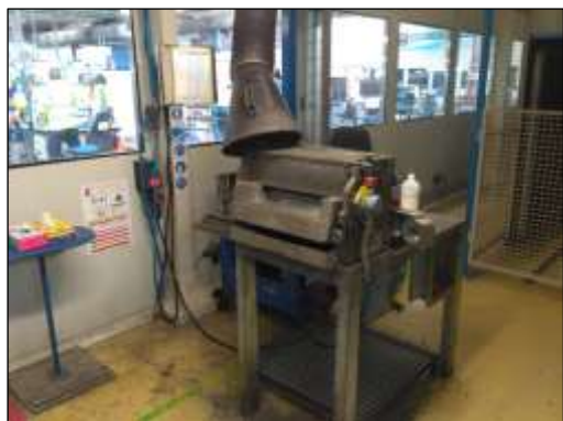
Detalle del proceso de recubrimiento por rodillos
